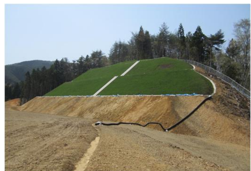
法面植生状況
