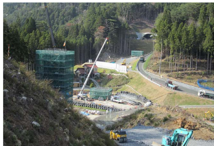
下部工構築状況
