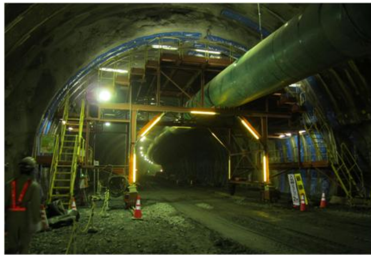
覆工施工状況
