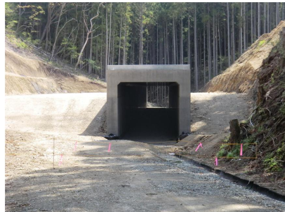
BOX施工状況
