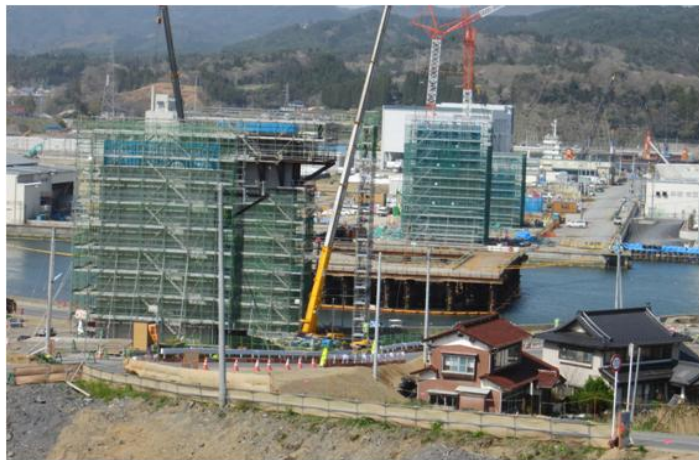
橋脚構築状況
