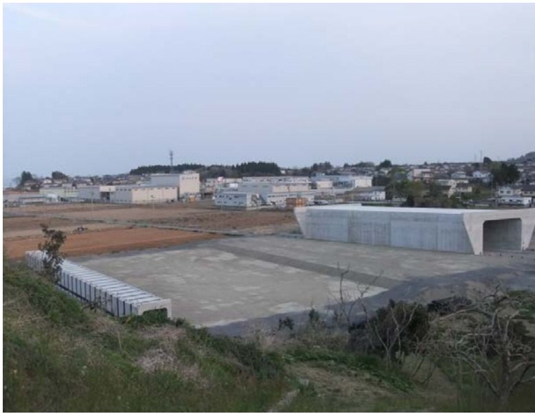
BOX構築状況
