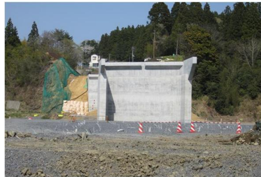
橋台構築状況
