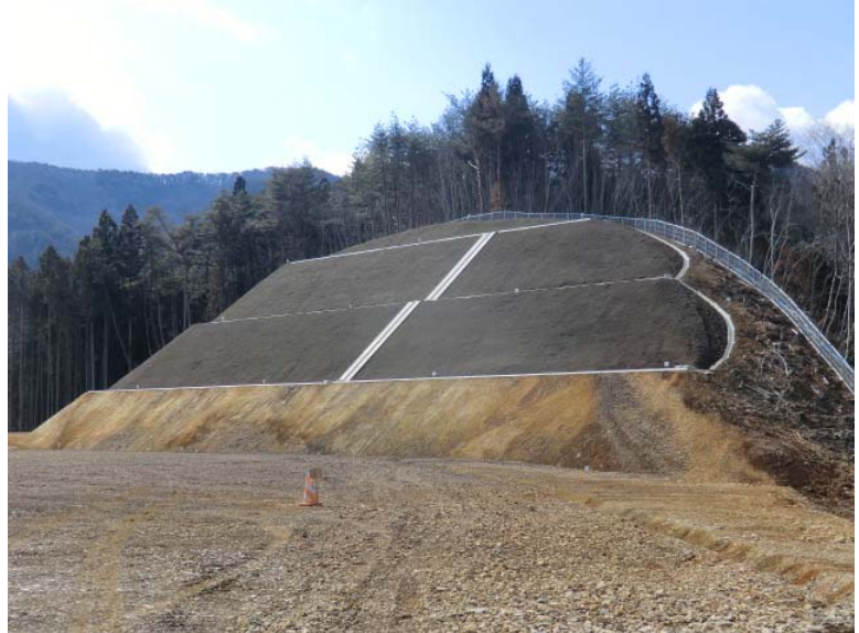
法面植生状況
