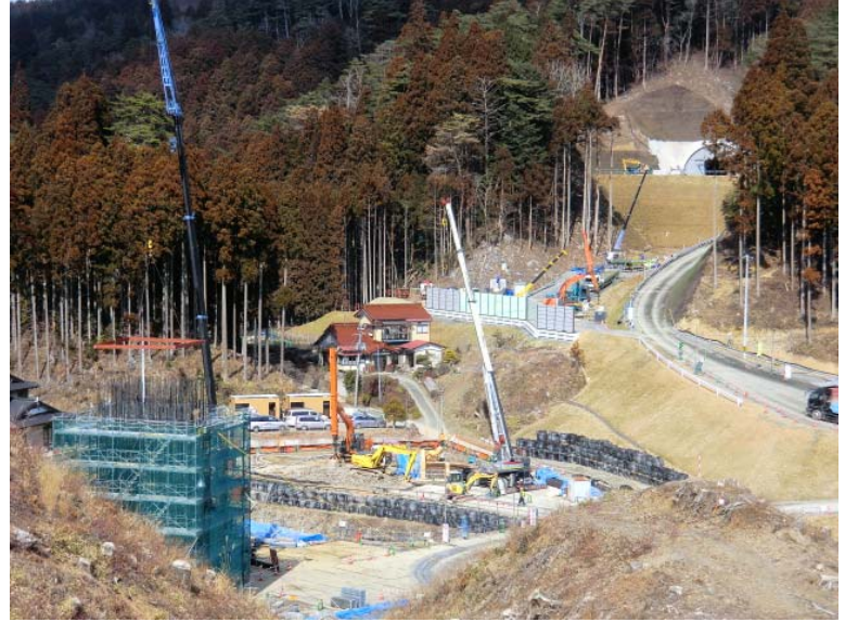
下部工構築状況
