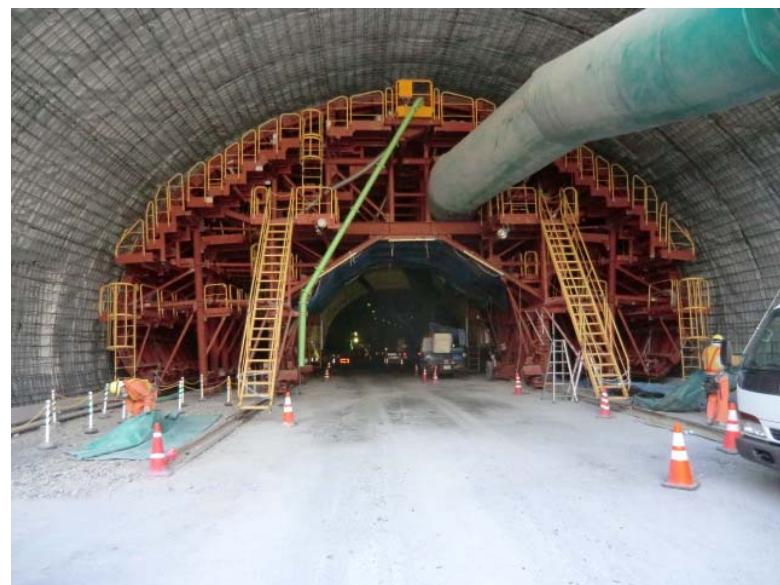
覆工施工状況
