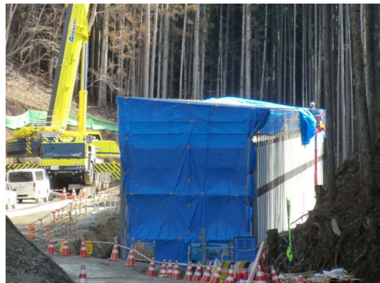
BOX施工状況
