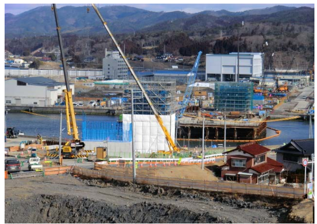
橋脚構築状況
