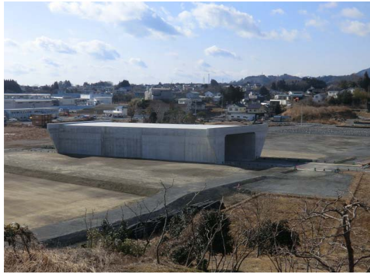
BOX構築状況
