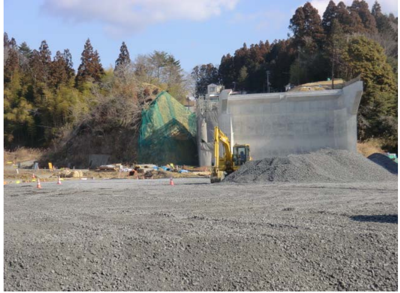
橋台構築状況
