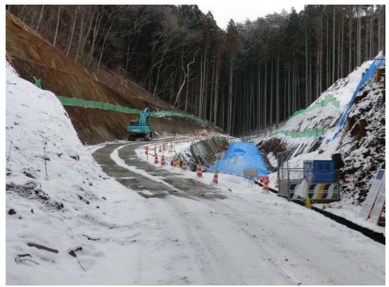
BOX施工状況
