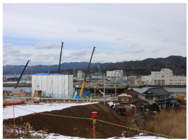
橋脚構築状況
