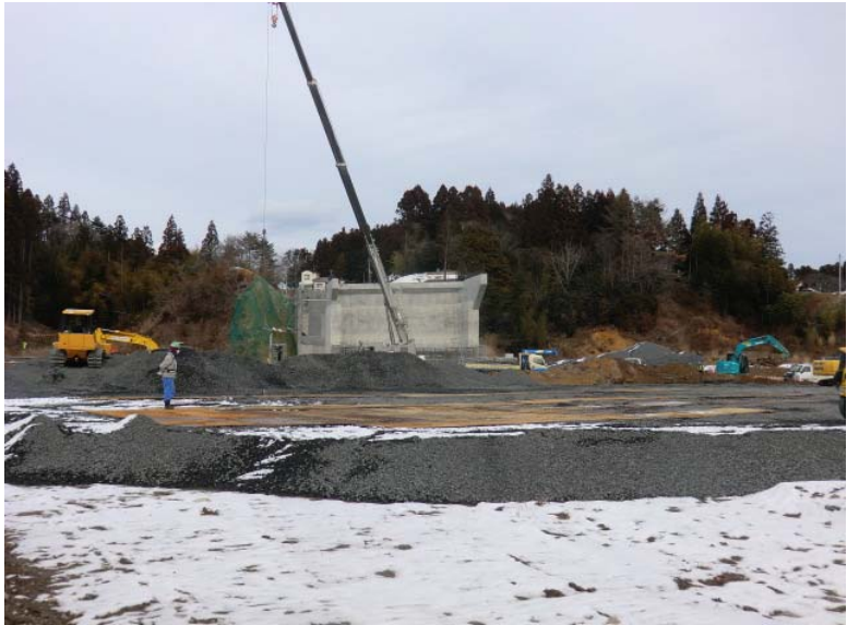
橋台構築状況
