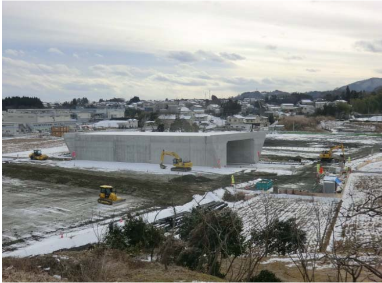
BOX構築状況
