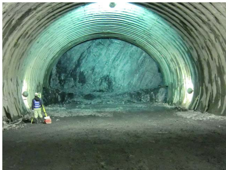
トンネル掘削状況
