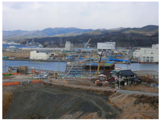
橋脚構築状況
