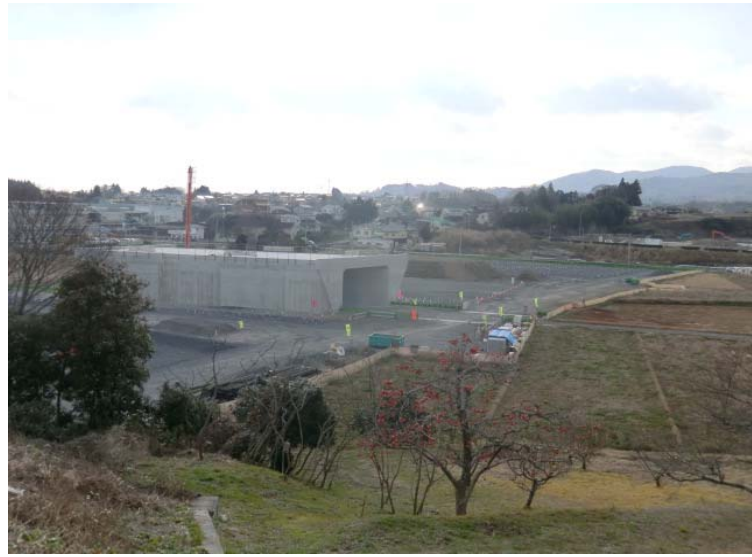
BOX構築状況
