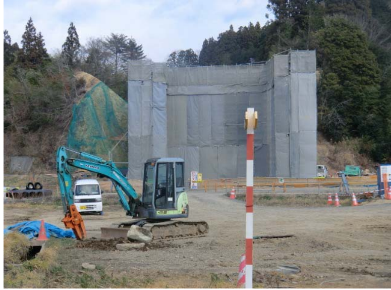
橋台構築状況
