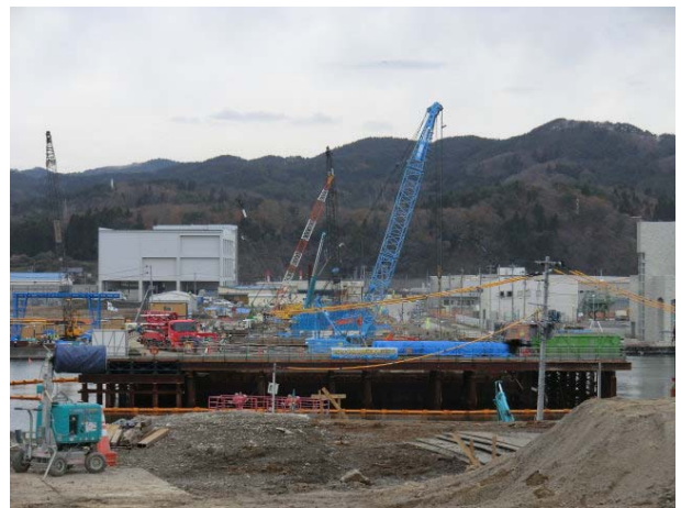
橋脚構築状況
