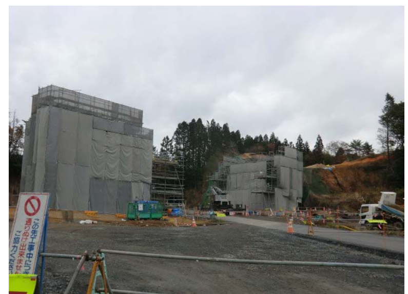
橋台構築状況
