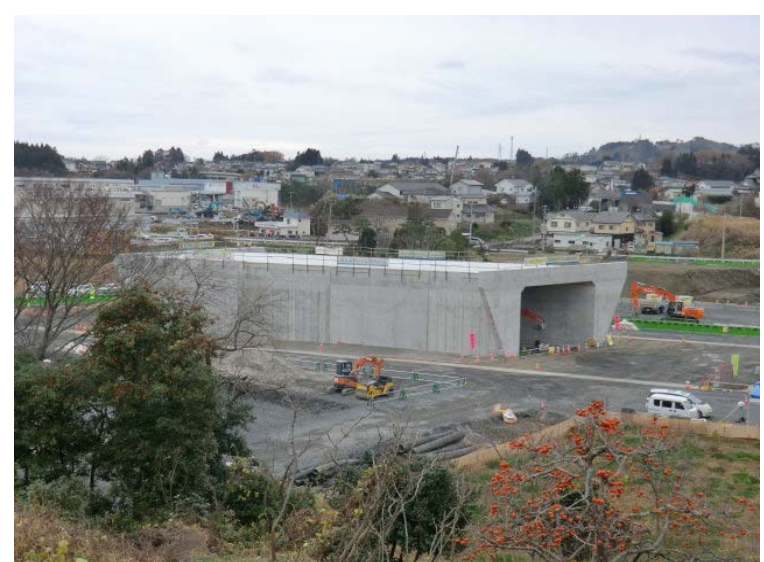
BOX構築状況
