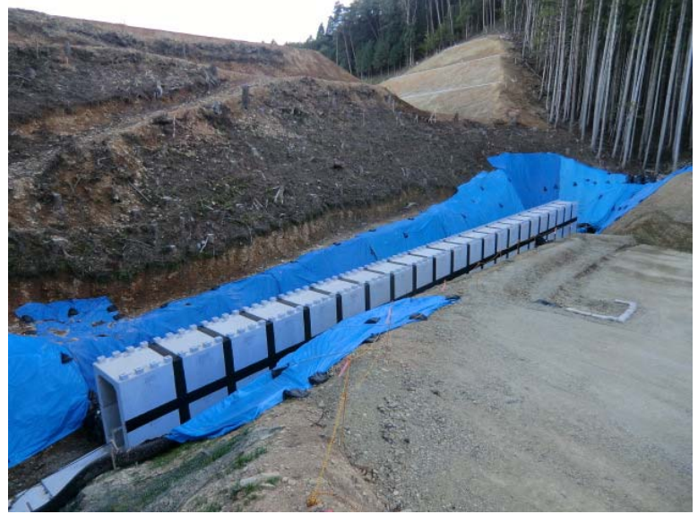
Box構築状況
