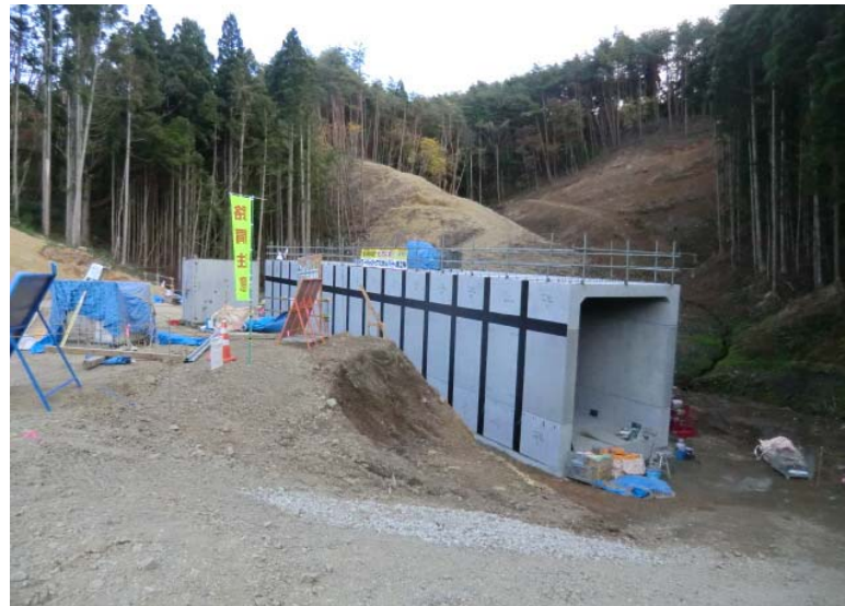
BOX構築状況
