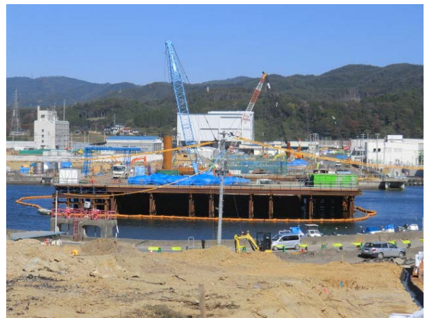
橋脚構築状況
