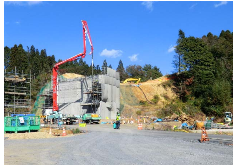
橋台構築状況
