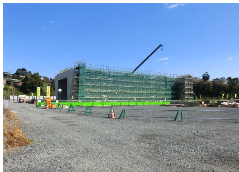
BOX構築状況
