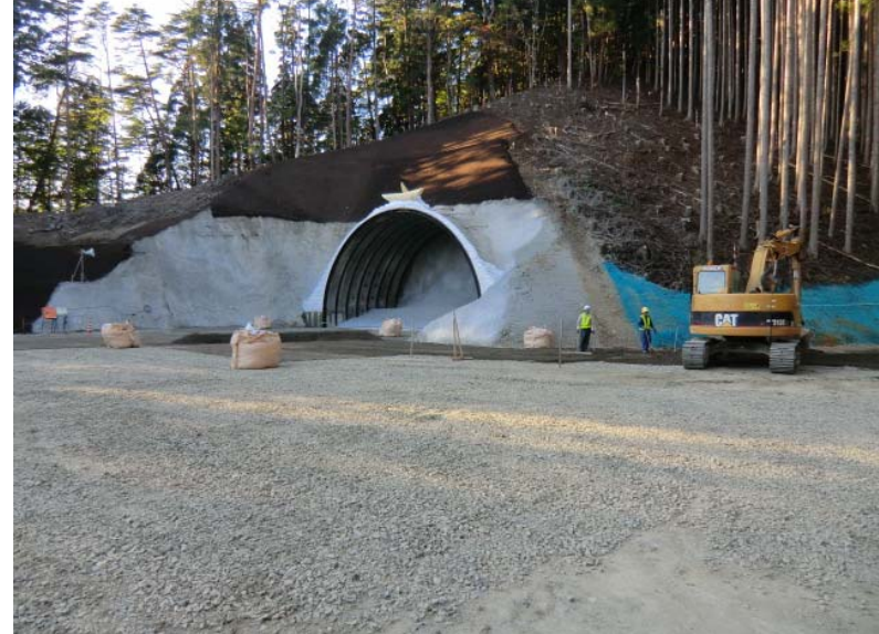
TN坑口付け状況
