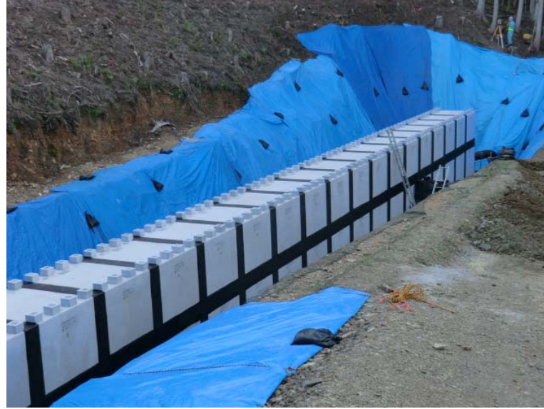
Box構築状況
