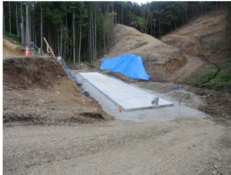
BOX構築状況
