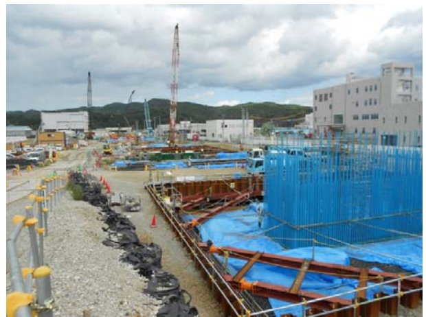
橋梁下部工施工状況
