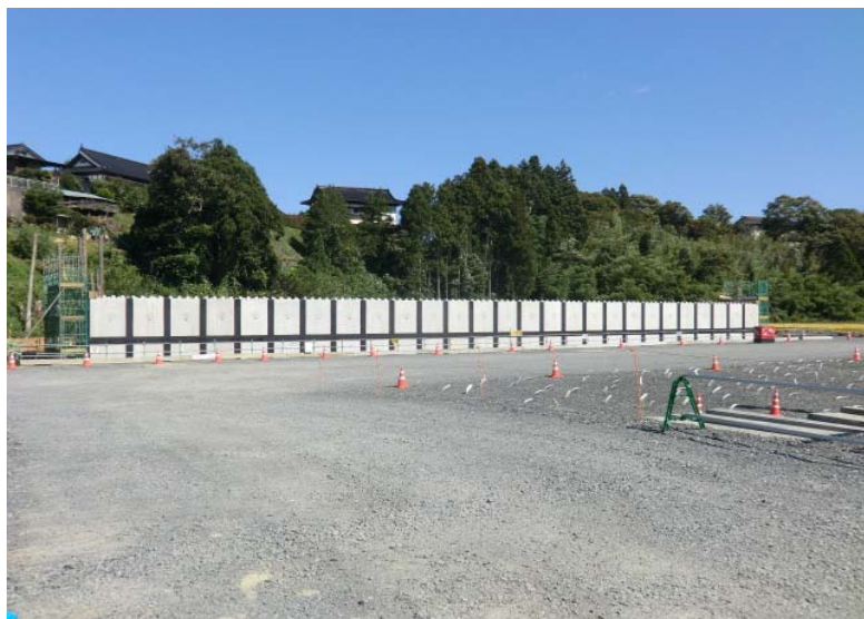
BOX構築状況
