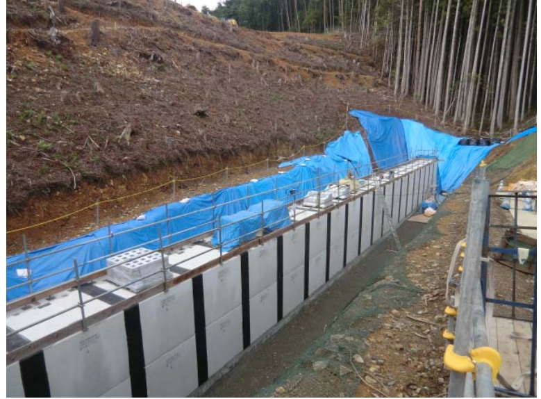
函渠施工状況
