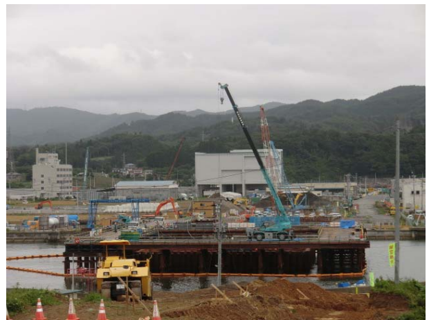
橋脚基礎工施工状況
