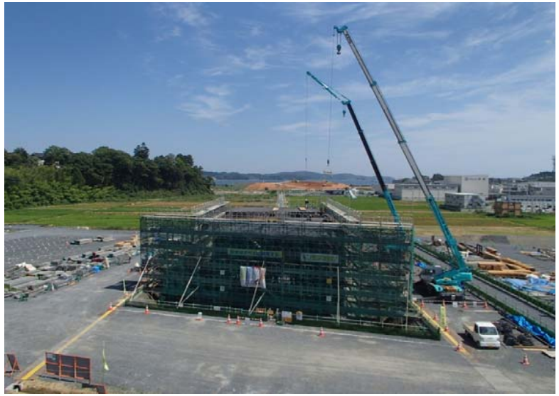
BOX構築状況
