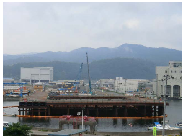
橋脚基礎工施工状況
