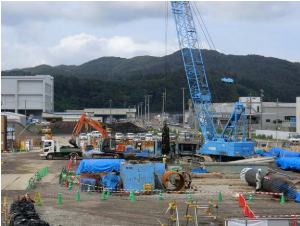
基礎杭施工状況
