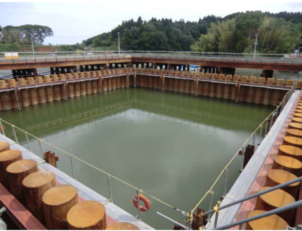
矢板締切状況
