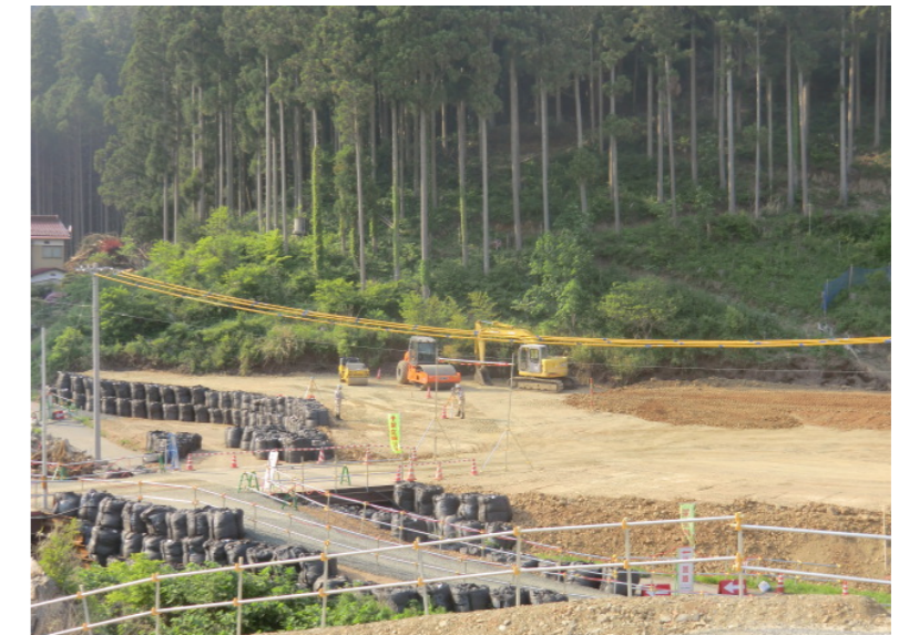
ヤード造成状況
