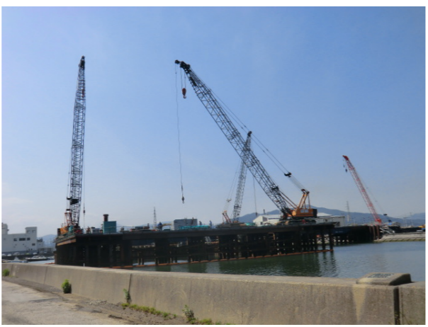
仮設構台施工状況
