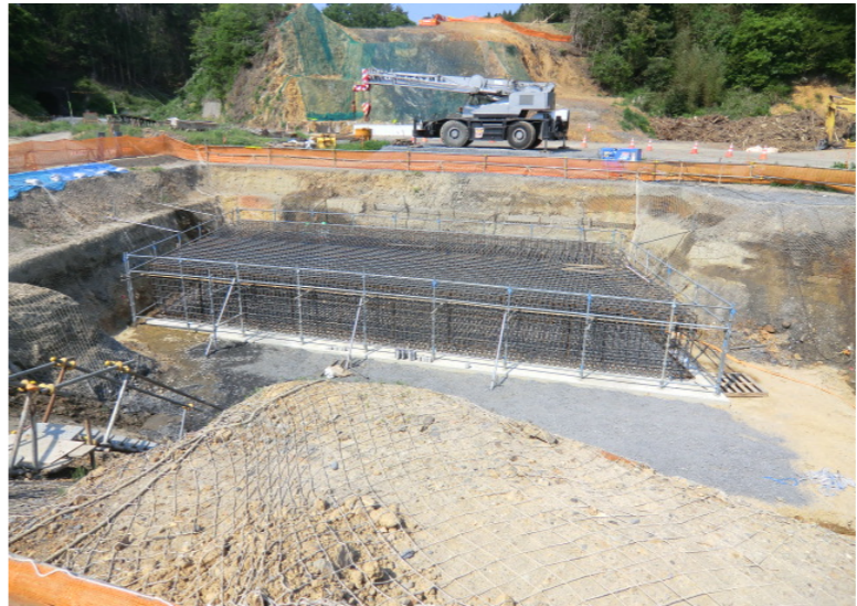
橋台床掘状況
