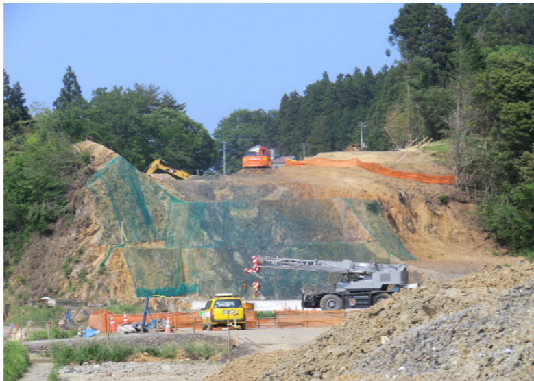
橋台床掘状況
