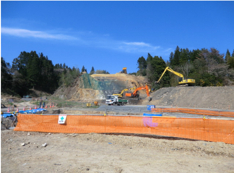
橋台床掘状況
