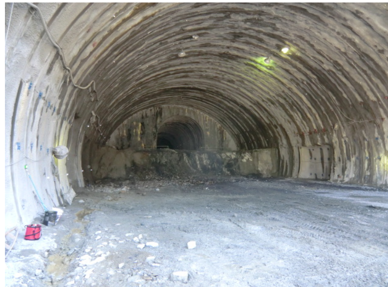
トンネル切羽状況
