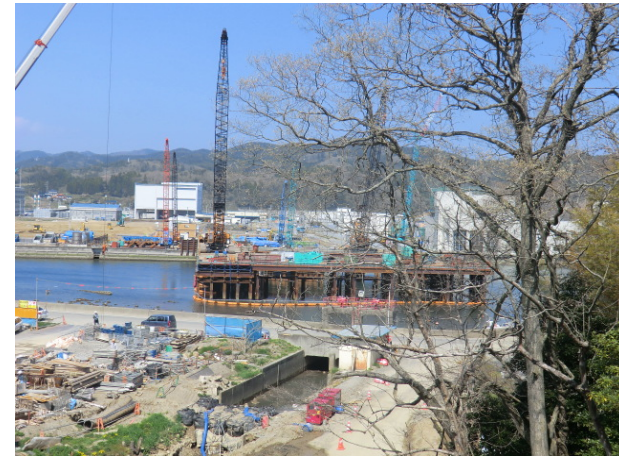
仮設構台施工状況
