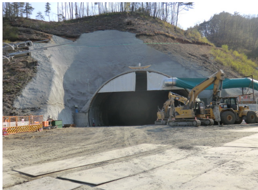
トンネル坑口状況
