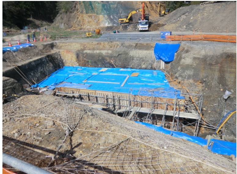
橋台床掘状況
