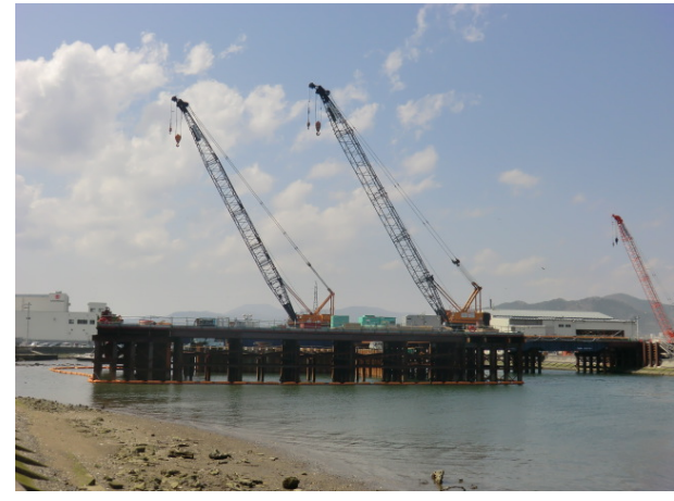
仮設構台施工状況
