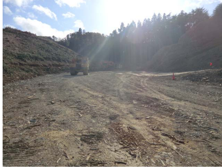
進入路造成状況
