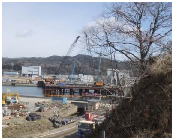
仮設構台施工状況
