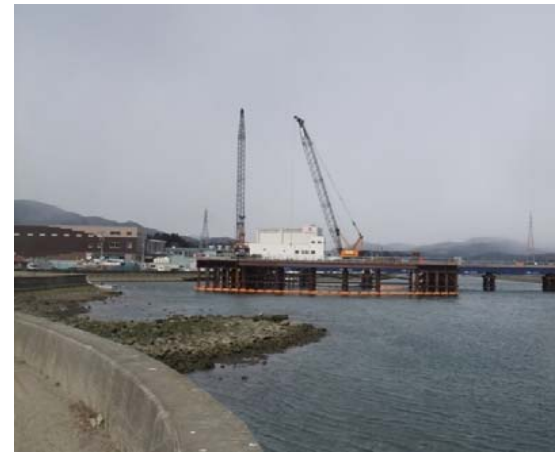
仮設構台施工状況
