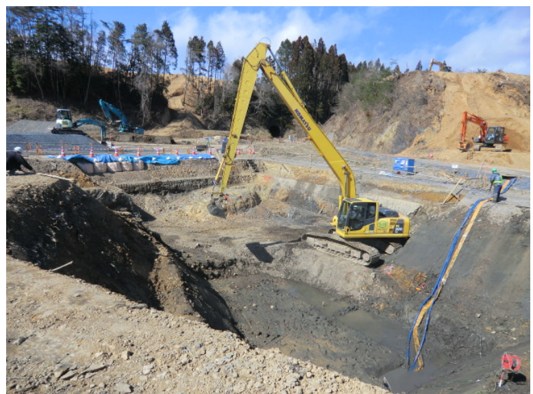
橋台床掘状況
