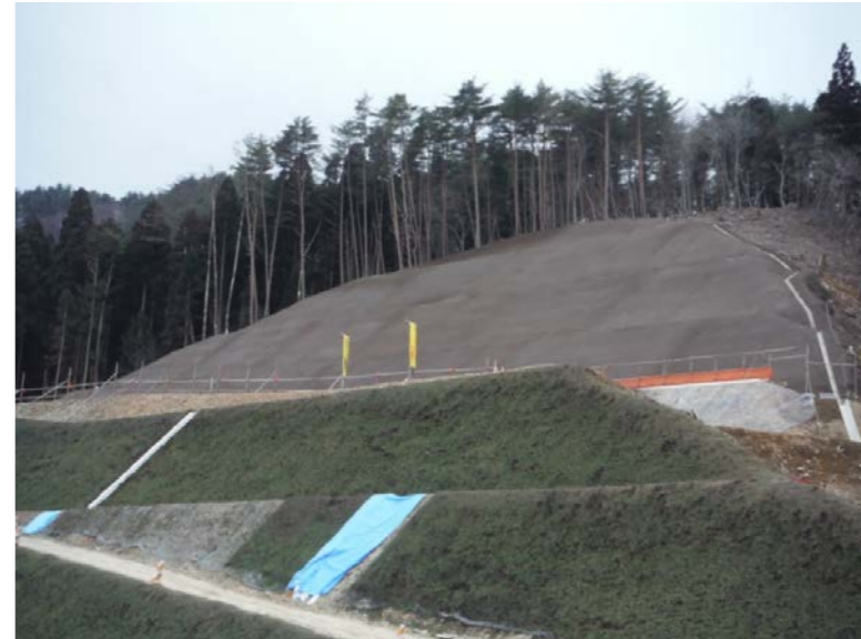
切土施工状況
