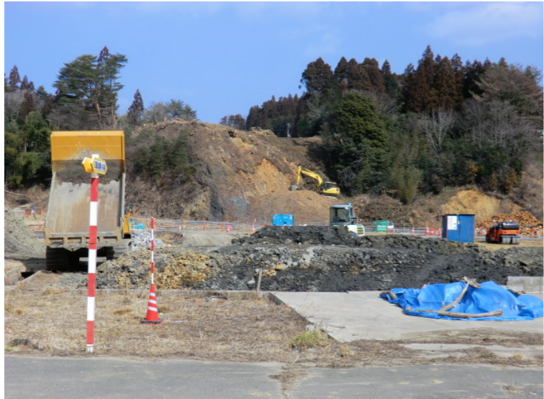
橋台床掘状況
