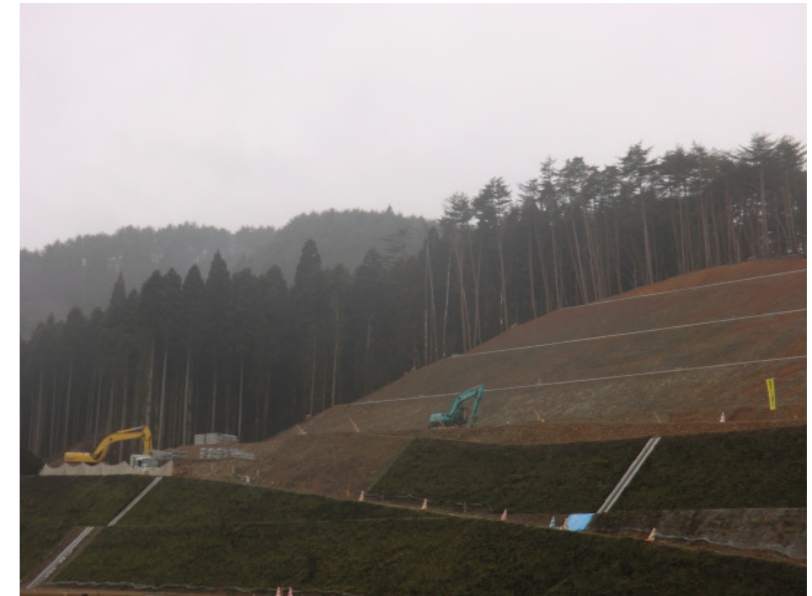
切土施工状況
