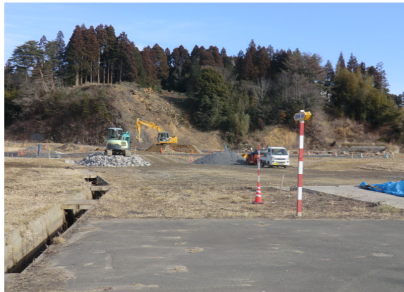
橋台床掘状況
