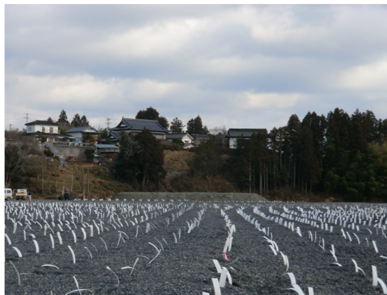
軟弱地盤対策工完了状況
