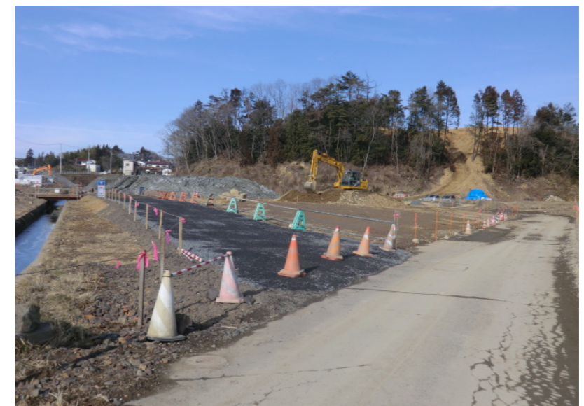
橋台床掘準備状況
