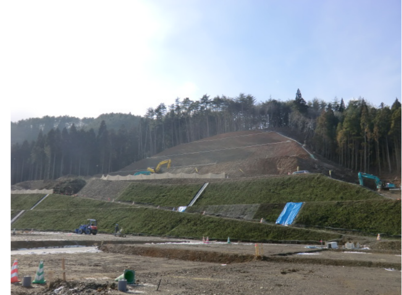
切土施工状況
