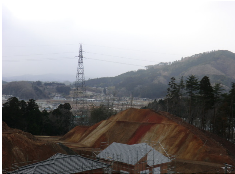
切土完了状況
