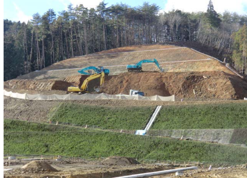
切土施工状況
