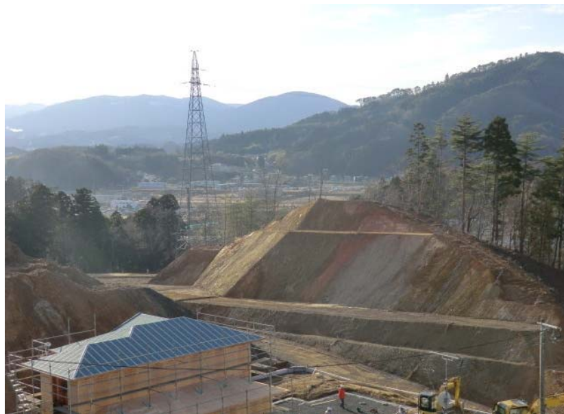
切土完了状況
