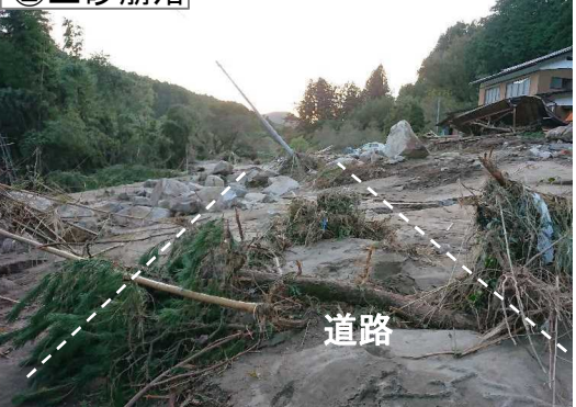
② 土砂崩落
