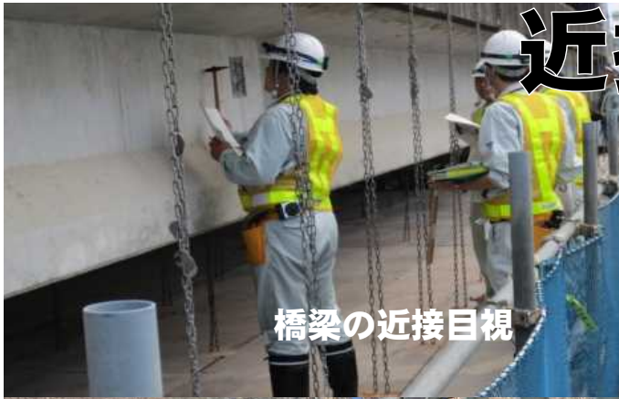
橋梁点検車による点検
