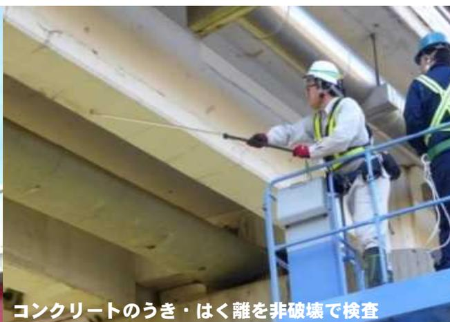
コンクリートのうき・はく離を非破壊で検査
