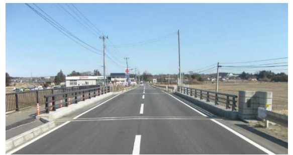
【対策】伸縮装置取り換え、高欄補修
