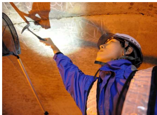
■ トンネルの近接目視
