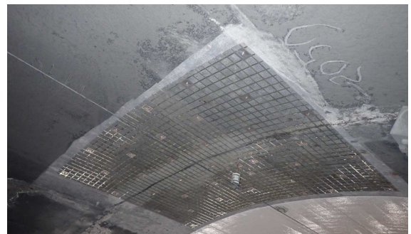
【対策】はく落防止(炭素繊維+メッシュシート)
