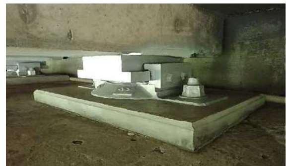
【対策】支承防錆
