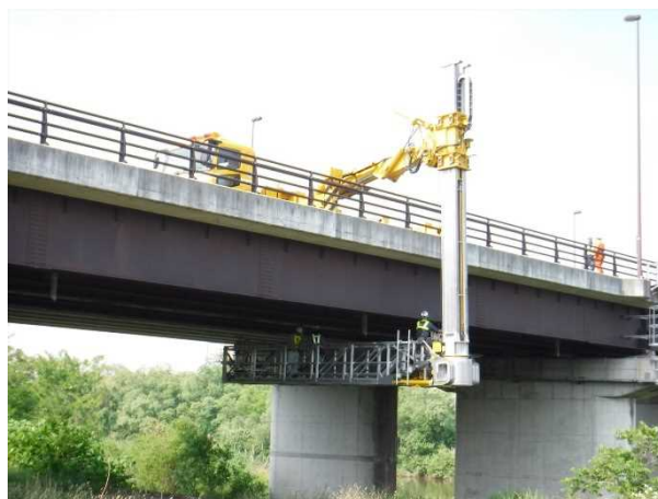
■ 橋梁点検車による点検
