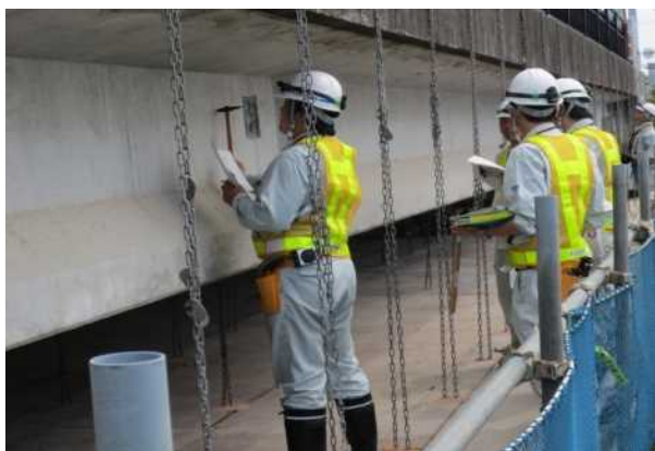
■ 橋梁の近接目視
