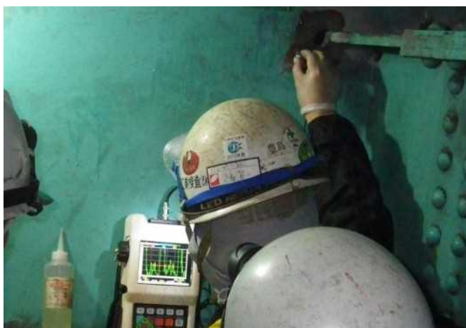
▲超音波探傷試験による鋼材内部のき裂測定
