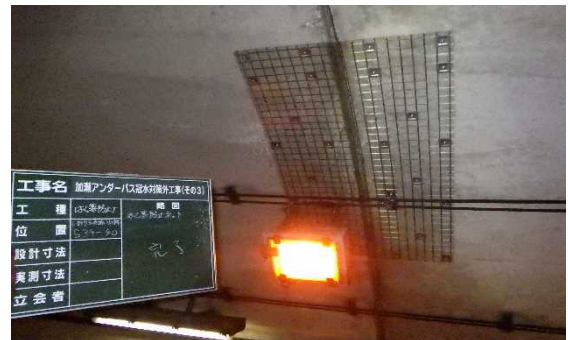
【対策】はく落防止（メッシュシート）
